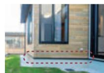
外壁仕上げ材の下部には、耐久性・防水性に優れたガルバリウム鋼板を施工
