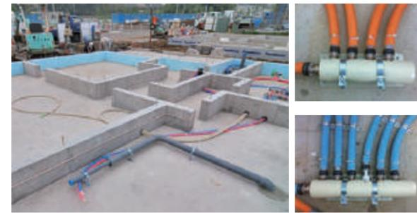
配管施工例 給湯・給水ヘッダー
