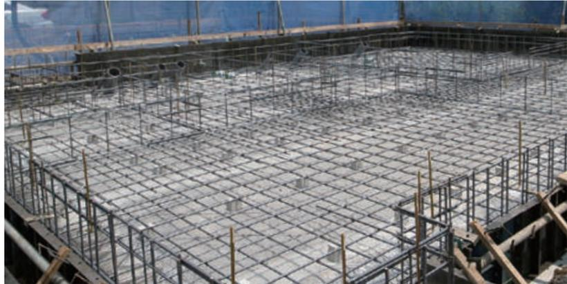
耐圧盤(コンクリートスラブ)配筋施工例
